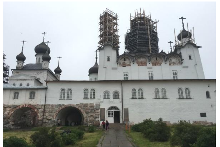
改修中のソロベツキー修道院
