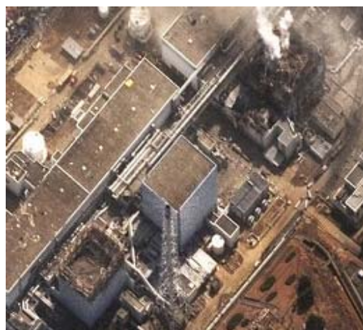
Фукусима-1 до катастрофы 1 (слева внизу) и 3 (сверху справа) реакторы после водородных взрывов.
